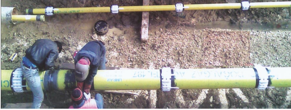
Şekil 3 PE hat (üstte) ve çelik hat (altta)
